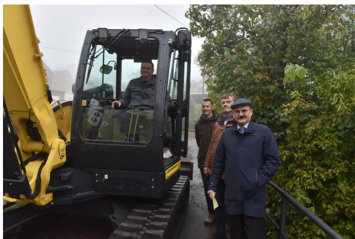
Im Herbst 2020 war Baggerbiss für den Bau der neuen Trinkwasserleitung in Johnsbach. Uwe Ahrendt mit Frank Kukuczka. © Egbert Kamprath
