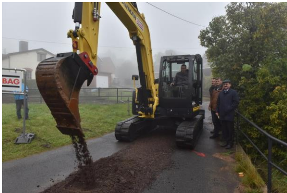
Am 16. Oktober 2020 setzt der amtierende Bürgermeister Uwe Ahrendt mit dem Bagger den symbolischen Spatenstich für das neue Trinkwasserortsnetz in Johnsbach. © Egbert Kamprath
