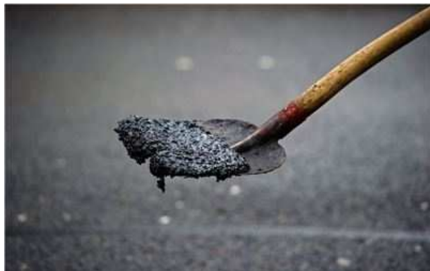
In der Dippser Siedlung wird ein Teil der Straßendecke wieder instandgesetzt.
