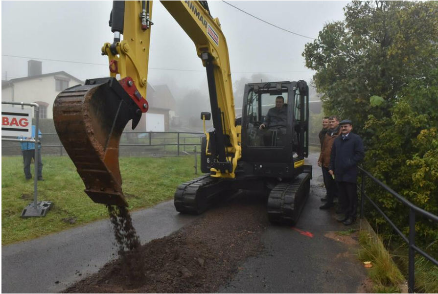
Bürgermeister-Stellvertreter Uwe Ahrendt nahm mit dem Bagger den ersten symbolischen Spatenstich vor. Ebenfalls mit dabei die Ortsvorsteher von Dittersdorf und Johnsbach, Frank Zimmerhäckel und Steffen Barthel, sowie Geschäftsführer Frank Kukuczka © Egbert Kamprath
